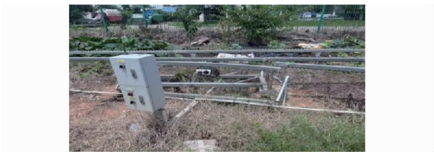
图 22 道岔变轨试验 Fig. 22 Turnout track change test
