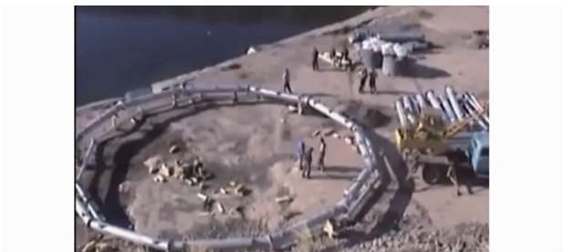
图 16 模块化自动升降式深海网箱运输和安装现场图
