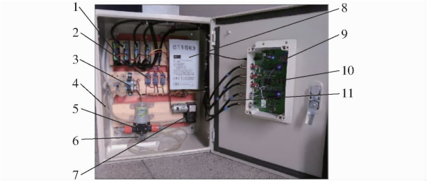
图 3 控制柜结构图
