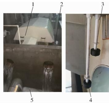
图 2 转鼓式微滤机及液位开关的安装图
