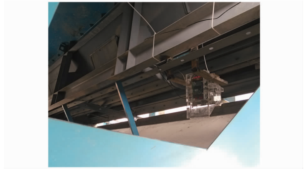
图 8 设备现场安装图
