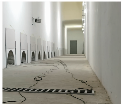
图9 风速及湿度传感器安装位置图
