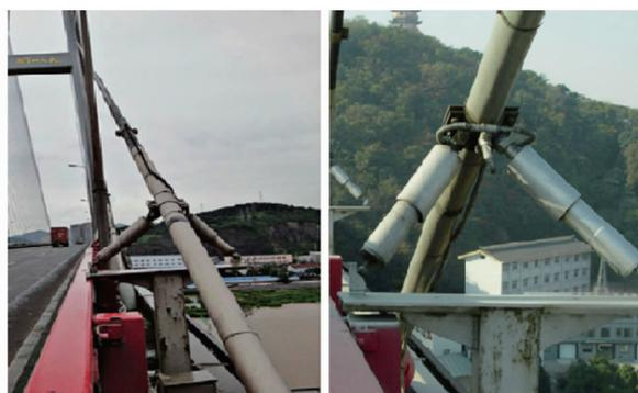
图 1 招宝山 C20 号拉索及阻尼器系统安装图
