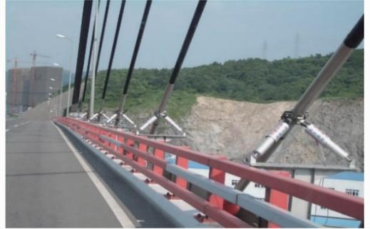
图 4 宁波招宝山大桥斜拉索-磁流变阻尼器系统
