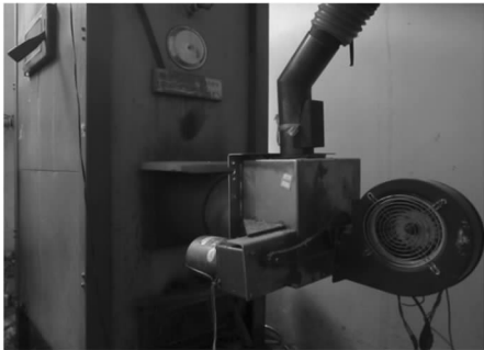
图 2 上进料式燃烧器的结构示意图 Fig.2 Structure diagram of up feed burner
